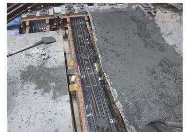
8. 乾燥収縮試験部分: 打設状況
